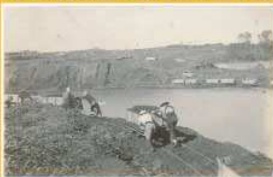
夕張川瀬削 (人力によるトロッコ土砂運搬)
